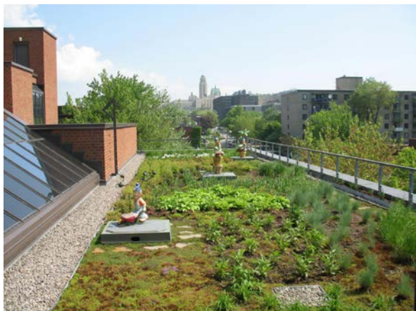
Casa de la cultura Costa de las Nieves. Techo verde. Foto: Ève Côté.
