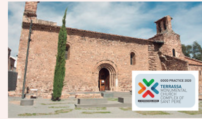
Terrassa Site monumental des églises de Sant Pere
